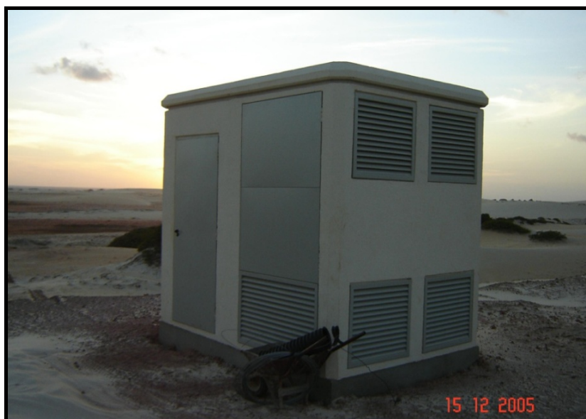
Figura 2.10 – Exemplo de uma Subestação Unitária Abrigada
